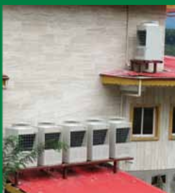
پروژه سالن دانشگاه آزاد کشاورزی رشت (مولتی اسپلیت (VRF) به همراه یونیت داخلی دیواری)
