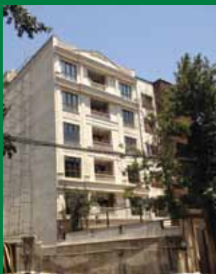
پروژه خیابان اندرزگو (فن کویل زمینی)
