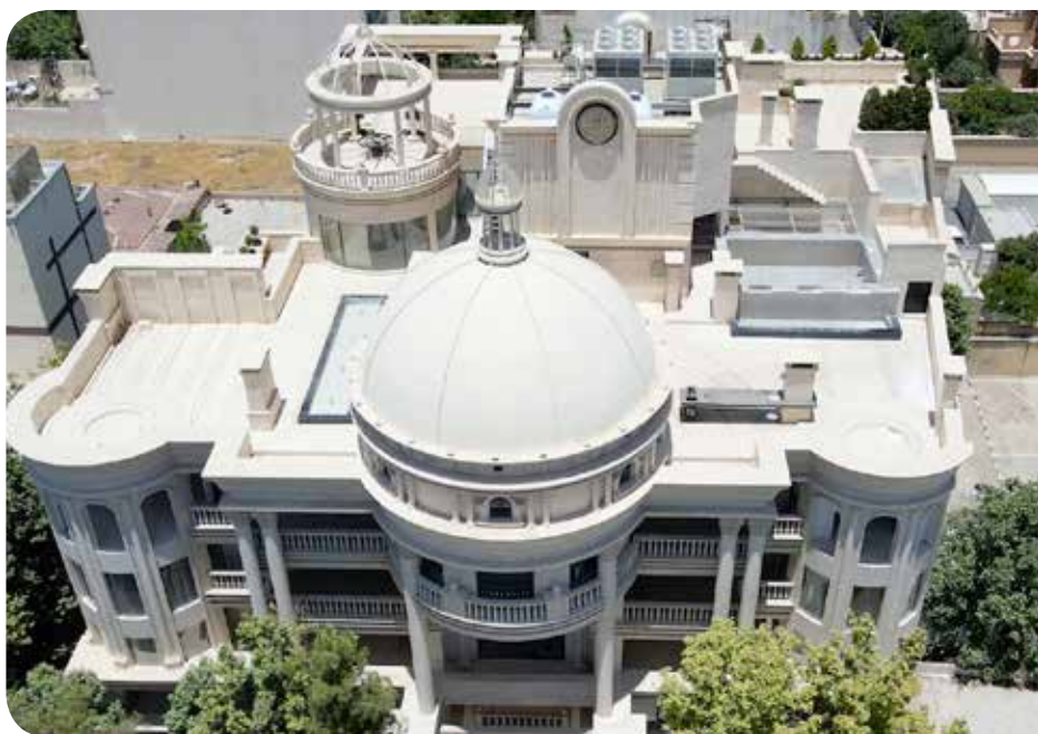
پروژه مسکونی Queen Residence / شیراز چیلر مایدیا
