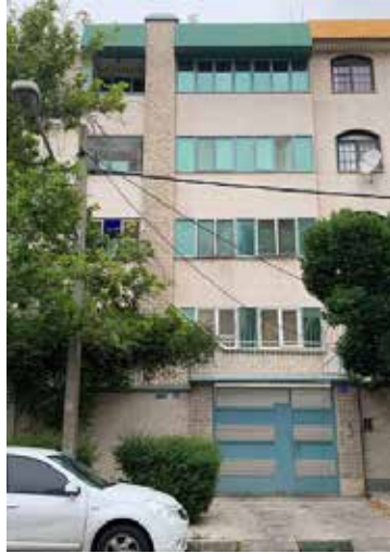
پروژه مسکونی - تهران چیلر تک الکترونیک فن کویل سقفی توکار مایدیا
