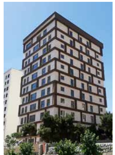
پروژه مسکونی - تهران فن کوپل سقفی توکار ماییدیا
